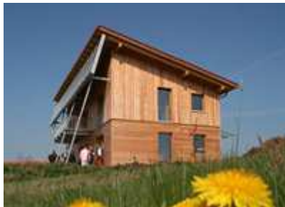
Neubau mit optimaler Anordnung der Kollektorfläche
