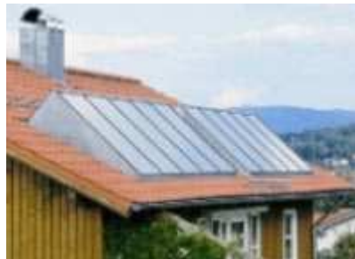
Altbausolarisierung: durch angehobene Montage der Kollektoren auf flachen Dächern lassen sich höhere Solarerträge erzielen. Im Beispiel rechts wurde die Dachform verändert (Firstverlängerung).
