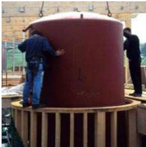
Einbringung eines Großspeichers
